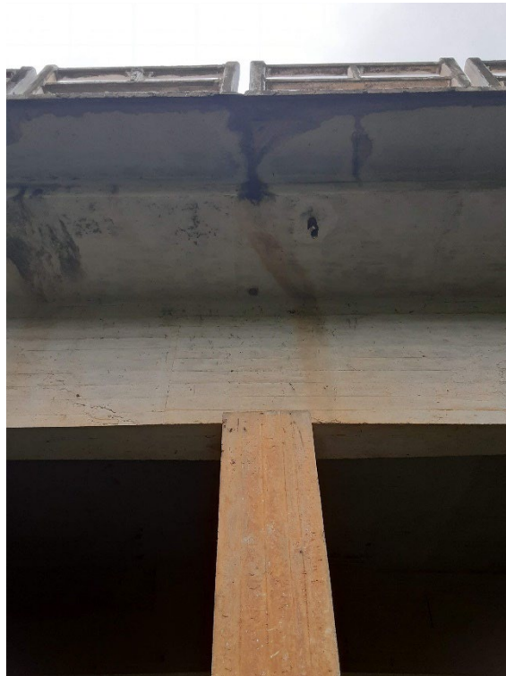
Figura 16 – Passeio rompido
