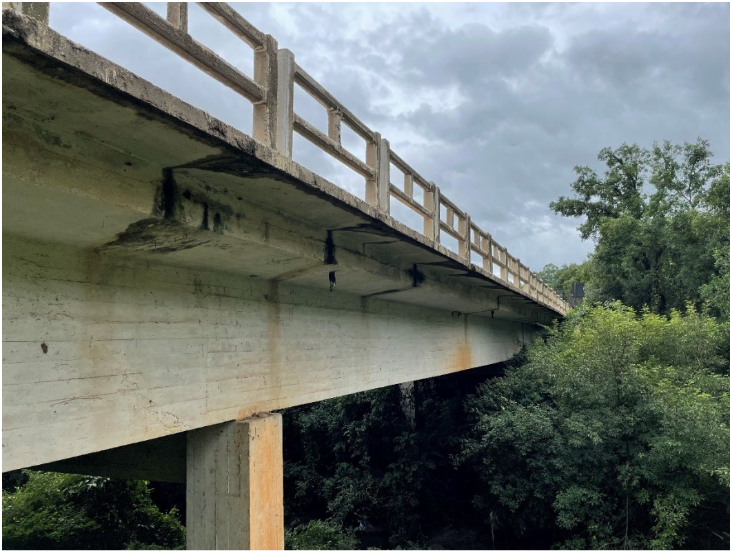
Figura 8 – Lateral da longarina e laje do passeio
