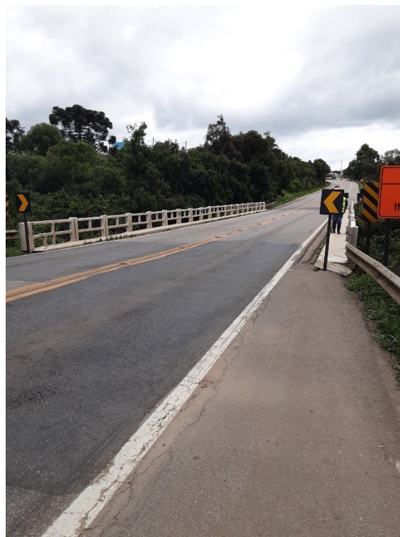
Figura 2 - Vista geral da ponte
