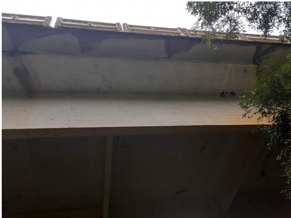
Figura 14 – Passeio rompido
