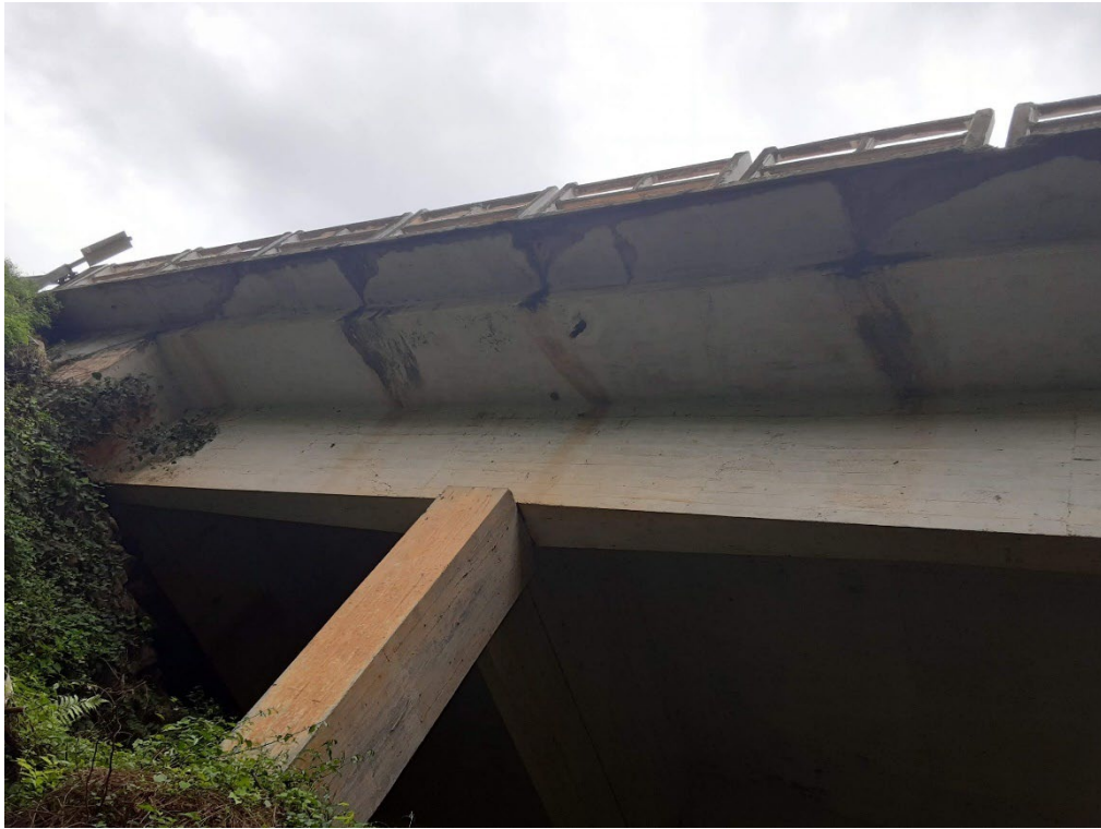
Figura 15 – Passeio rompido
