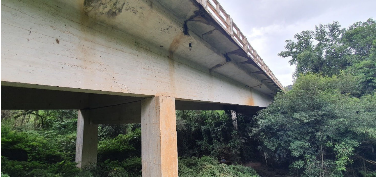
Figura 11 – Passeio rompido
