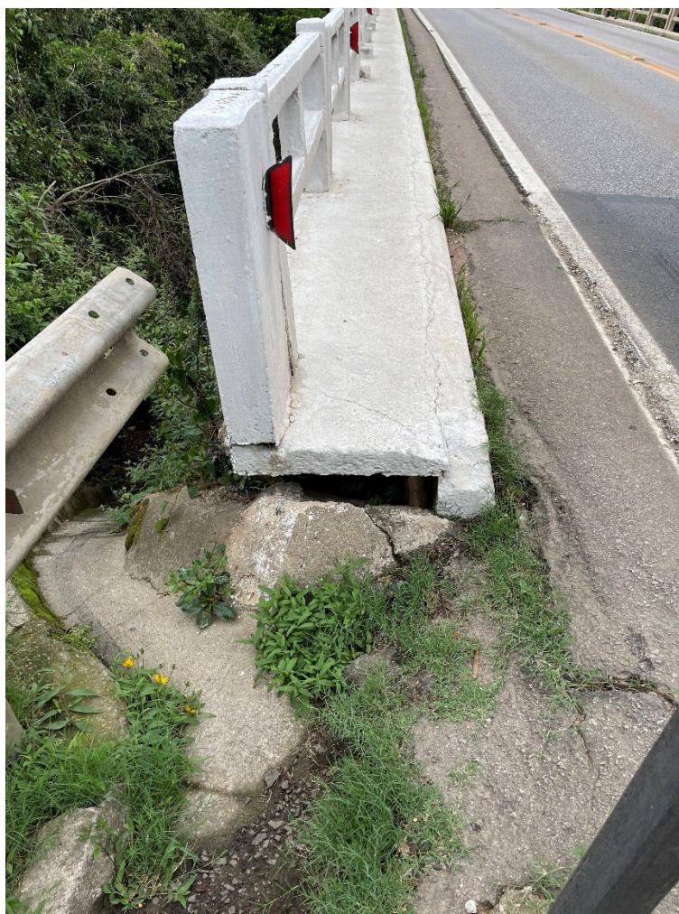
Figura 17 – Passeio rompido
