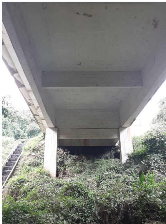
Figura 3 – Vista geral da parte inferior da obra
