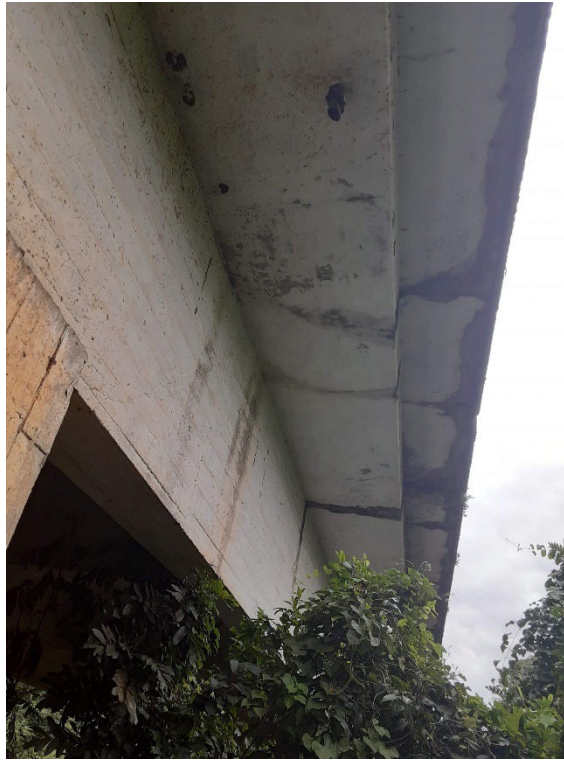
Figura 13 – Passeio rompido
